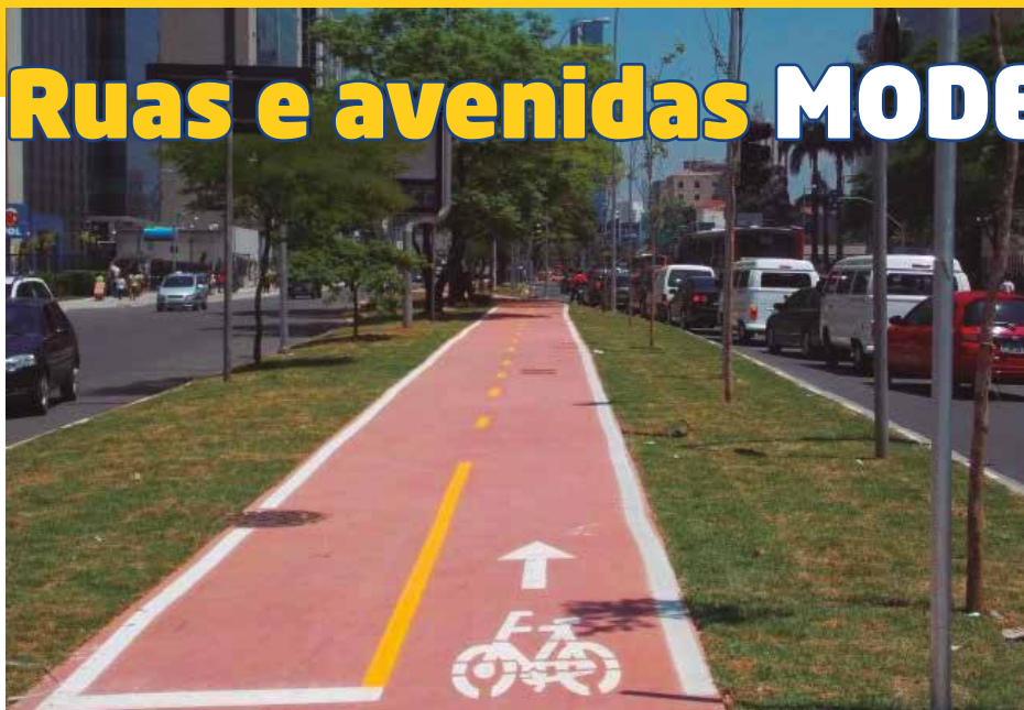
Faria Lima: fios enterrados e ciclovia
